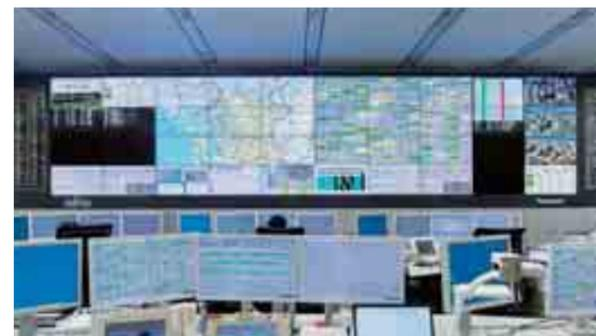
リアルタイムに集約される消防情報を映し出す、室内モニターとしては国内でも有数の規模となる55V型・縦4面×横10面の大型マルチスクリーンを導入。
