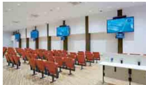
2017年3月に移転し、リニューアルオープンされた外向発売所ドリームピット。新館の設立に伴い、施設内の映像表示機器も全面的に更新。一般席のメインモニターには、4K液晶ディスプレイTH-98LQ70Jを4台設置。レース実況放送も、よりスムーズな表示が可能。各レースのスタート前には、4分割マルチ画面にオッズ情報や成績など、細かな文字情報まで鮮明に表示しています。また、8場分のレース状況を提供できるよう、天井吊りにてTH-43LFE8Jや、TH-55LFE8Jが横並びに設置。他にも、明るく広々とした館内空間に、さまざまなディスプレイがそれぞれの目的に合わせ、効果的に配置されています。
