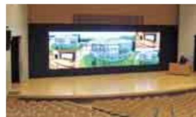
600名収容の大講義室に、4K映像表示対応の55V型×32面マルチスクリーンシステムを構築。
